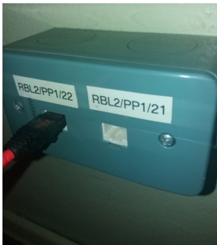
Fig. 7: Ponto de rede x2 devidamente identificado.
